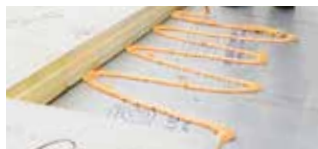
Isoleren van platte daken (min. 5 lijfstrengen per m)
