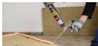
Isoleren van binnenmuren & gemene muren
