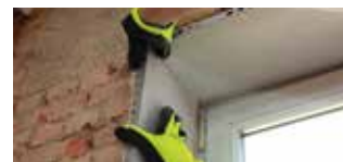
Uitbekleden van dagkanten
