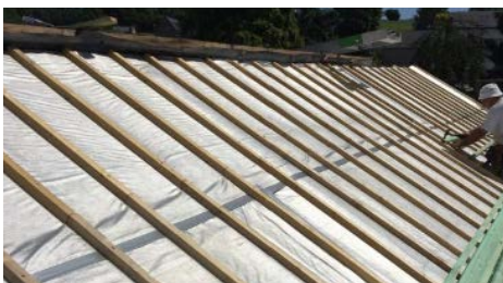
Hellend dak afwerken: buiten
